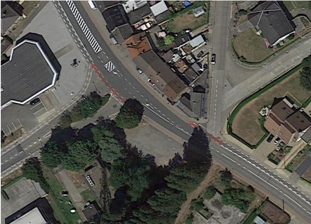
Afbeelding 58 Bestaande toestand kruispunt Industrielaan-Ninovesteenweg-Nachtegalstraat
