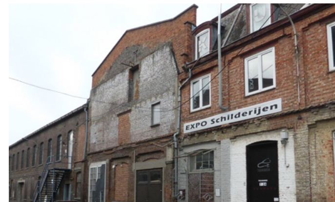
Zicht op de zuidgevel van drieledig magazijn
