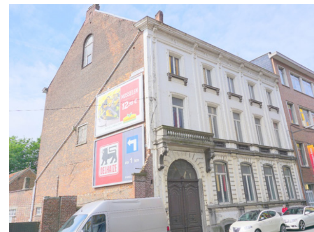
Zicht op de straatgevel vanuit de Vaartstraat
