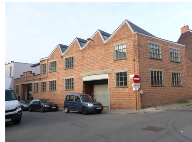
Zicht op het fabrieksgebouw vanuit Hertshage
