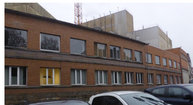
Zicht op zijvleugel poortgebouw vanuit de Burchtstraat
