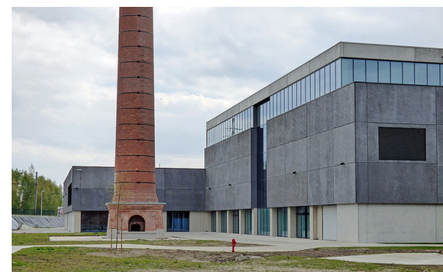
Zicht op de schouw thv Dender vanuit noordzijde
