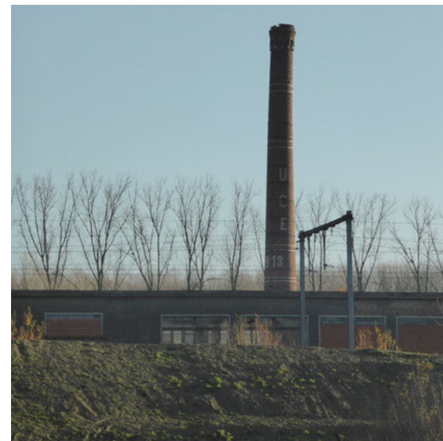
Zicht op de schouw vanuit westelijke richting
