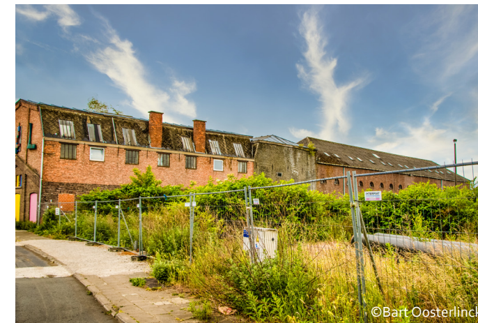
Zicht op noordgevel gevel drieledig magazijn
