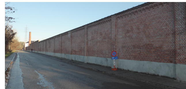
Zicht op de muur langsheen de Kapellekesbaan
