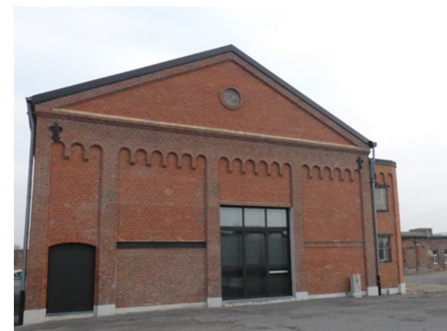
Zicht op achtergevel van de 'filatuur' vanuit westzijde
