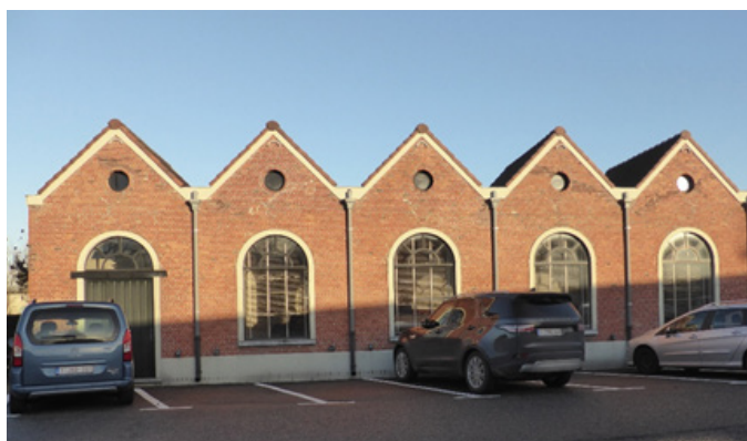
Zicht op de zuidgevel bijgebouw met vijf traveeën
