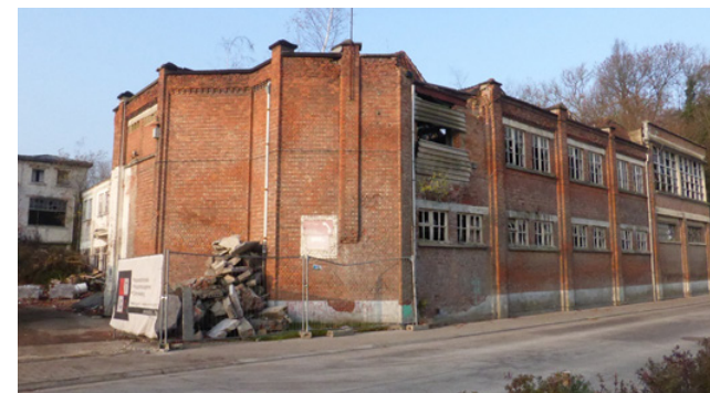
Zicht op de oostgevel vanuit De Erembodegemstraat
