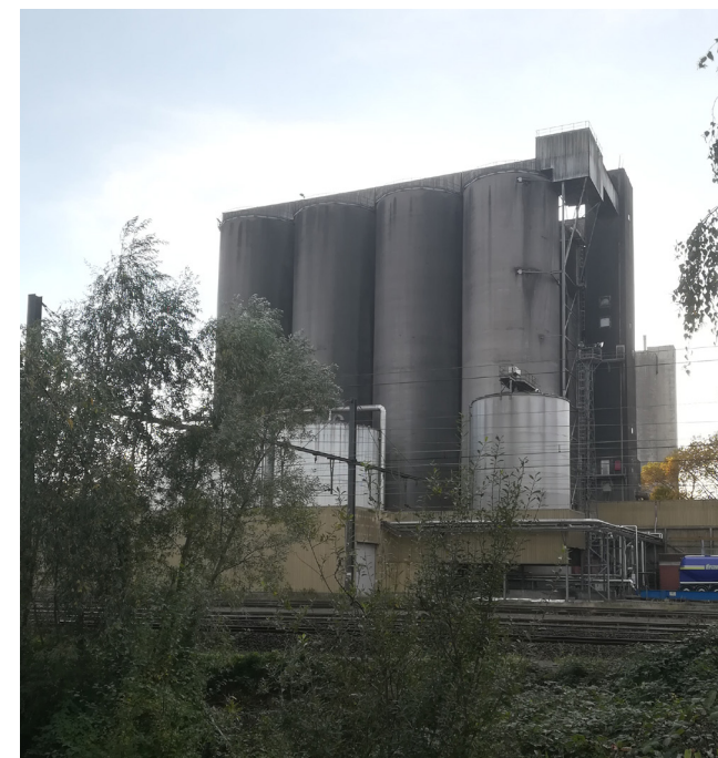
Zicht op graansilo's vanuit Bleekveld
