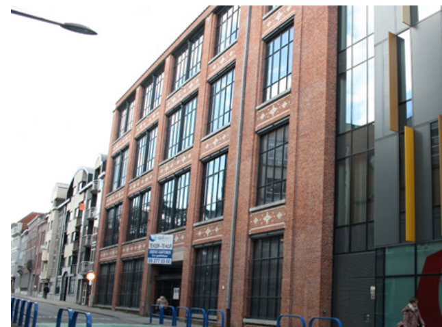
Zicht op het Manchestergebouw vanuit Vaartstraat
