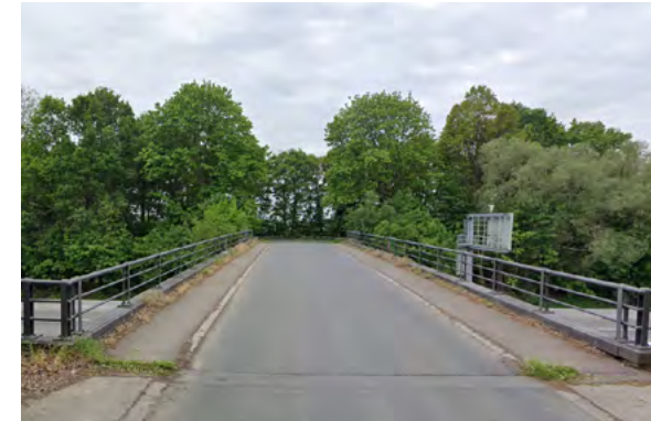
Figuur 102 brug Balleistraat
