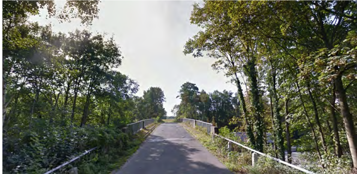
Figuur 14 bestaande toestand brug Ten Bos
