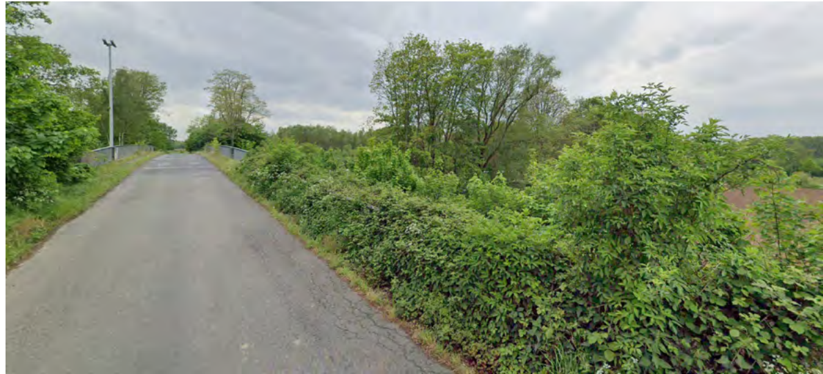
Figuur 105 bestaande toestand brug Ten Bos
